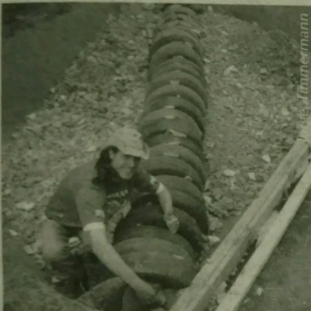
Fermentador de pneus cercado por entulho.
