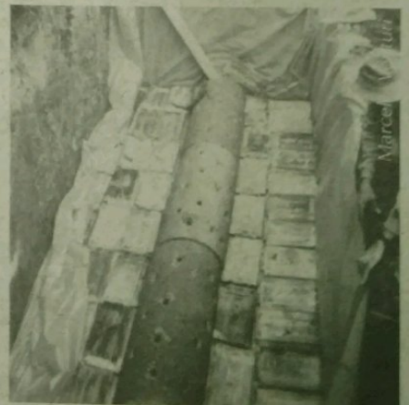
Fermentador de manilhas furadas com impermeabilização de lona plástica.
