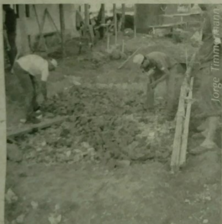
Camada de pedras que antecede as de brita, areia e solo.
