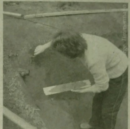
Revestimento com massa (2:1 areia lavada e cimento) sobre tela na parede chapiscada.
