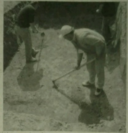
Abertura da vala.
