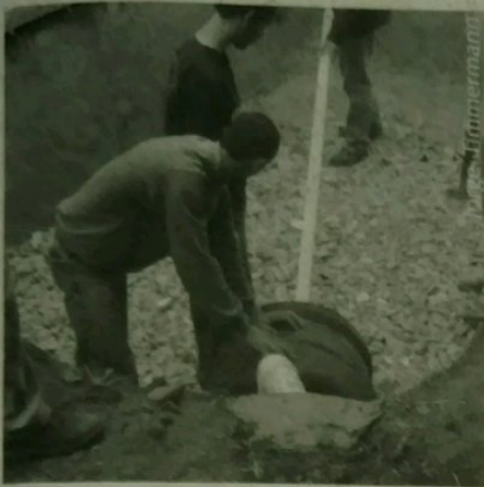
Fermentador de pneus em construção.
