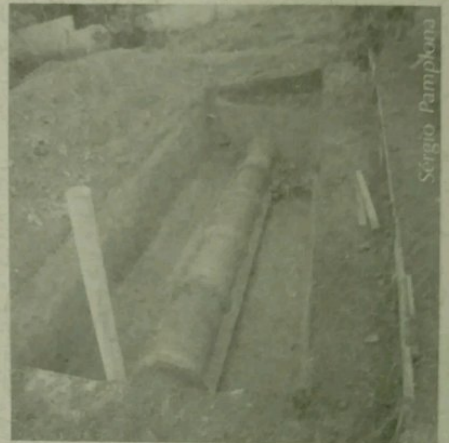
Fermentador de manilhas sobre tijolos, ao fundo vê-se o tubo "ladrão".
